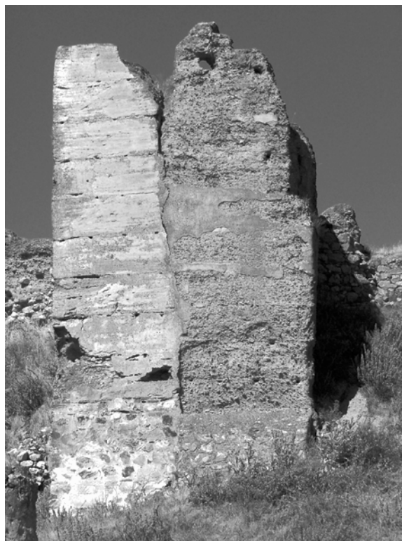
Fig. 1 – Torre almohade rehecha en el Castillo de Hornachos. Nótese la no coincidencia de las hiladas de las tapias.
