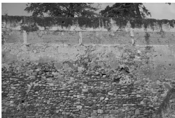
Fig. 7 – Lienzo oriental en la Alcazaba de Badajoz. En la parte superior se pueden apreciar los acabados epidérmicos originales sobre las tapias almohades. La zona inferior fue parcheada por los aliados angloespañoles en 1811.
