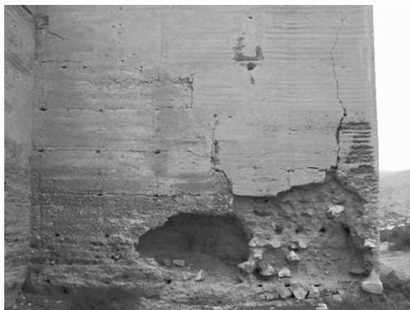
Fig. 2 – Zona inferior de una torre del recinto urbano almeriense en el Cerro de San Cristóbal. El lienzo que asoma a la izquierda y la refacción de la torre en la parte derecha son reformas atribuidas al período almohade, en las que se repara el muñón taifa de la parte izquierda.
