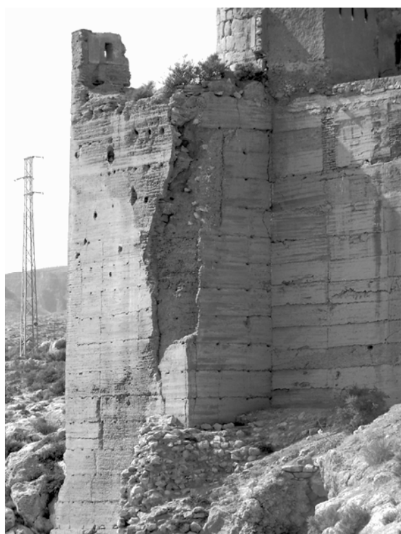
Fig. 4 – Torre esquinera en el Cerro de San Cristóbal, Almería. La parte derecha de la torre constituye el muñón de época taifa sobre el que se erige la torre de mampostería que asoma detrás. A la izquierda se aprecia la obra almohade que se adosa sobre la torre de mampuestos y referido muñón. Nótese la no correspondencia entre las hiladas de Tapia. Lo que se percibe del lienzo de muralla en la parte derecha de la imagen es producto de una restauración de mediados del siglo XX.
