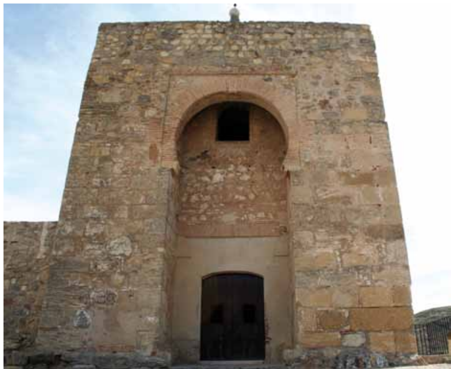
Vista general de la Puerta de Málaga de Antequera desde el sur
