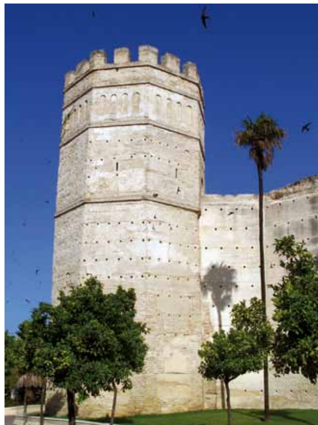
Vista general de las fortificaciones almohades de Jerez de la Frontera ejecutadas con tapias de hormigón de cal.
