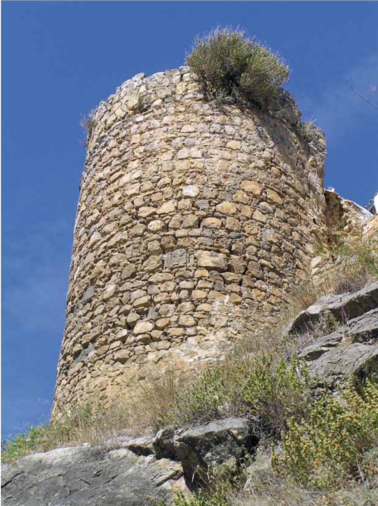
Vista general de la torre 9, construida con mamposterías enripiadas (fábrica 3).
