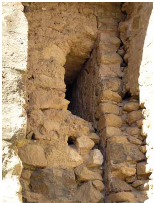
Detalle de la obra anterior a la construcción de la actual Torre del Homenaje, visto desde intramuros.
