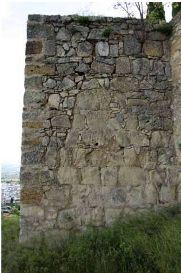
Detalle de la cara sur de la torre 20, con la presencia de las fábricas 2 de época nazarí en la parte inferior no restaurada.
