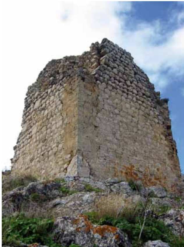
Detalle de las fortificaciones de Archidona construidas en época de Muḥammad V.
