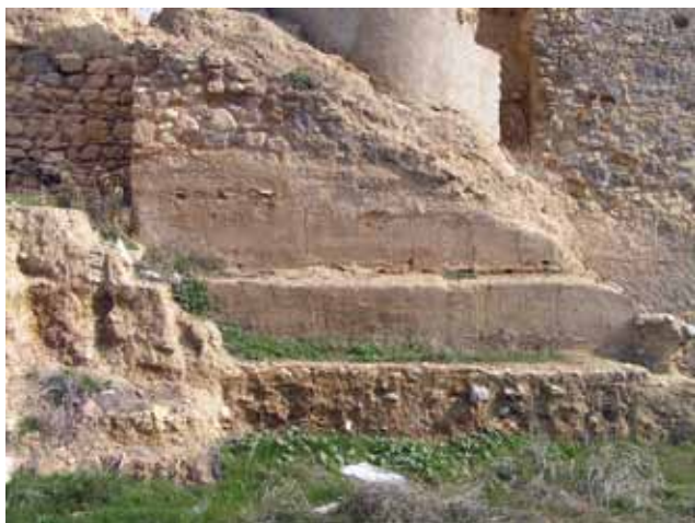
Vista general de la torre 4 de hormigón de cal puesta en obra con tapias.
