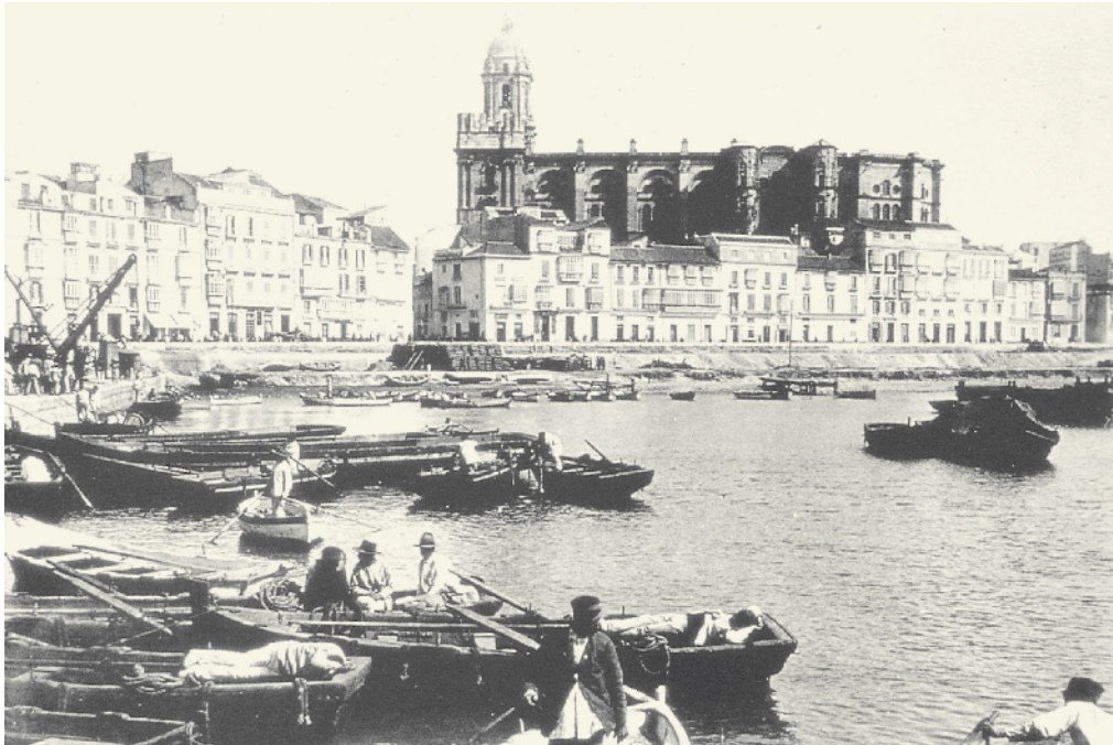
FACHADA DESDE EL MAR. CORTINA DEL MUELLE Y ACERA DE LA MARINA. ARCHIVO TEMBOURY.
