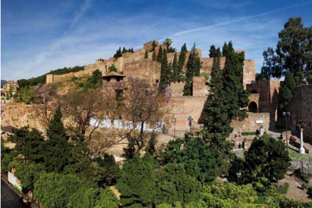
VISTA PANORÁMICA DE LA ALCAZABA. VUE PANORAMIQUE DE L'ALCAZABA.
