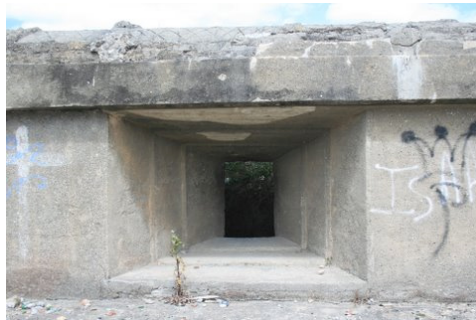
Lámina 35. Fortín con troneras de deriva exterior lisa, en Litoral Este, Tarifa.
