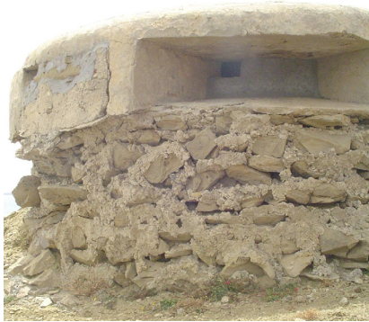
Lámina 35. Fortín con troneras de deriva exterior lisa, en Litoral Este, Tarifa.
