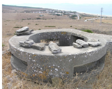
Lámina 26. Pozo de gola en Bolonia, Tarifa. Caso habitual de replanteo circular.
