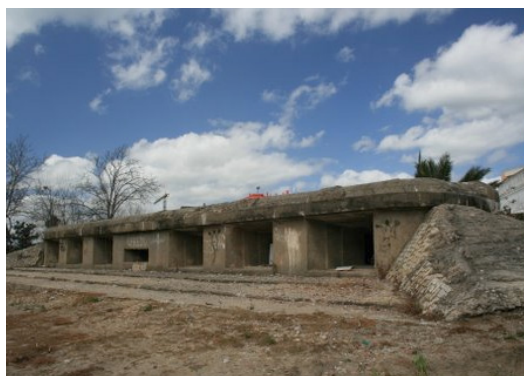
Lámina 10. Obra acasamatada en el istmo de La Línea, formada por una posición en galería con seis puestos de artillería y uno central de ametralladora, todo ello integrado en un bloque compacto de poca altura.
