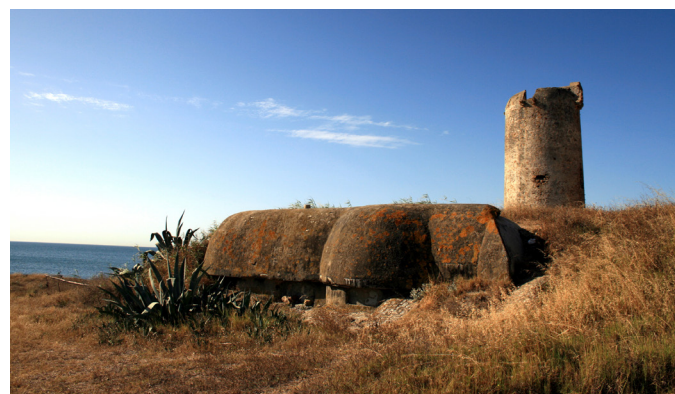
Figura 5. Fortines en caverna a pie de playa empotradas en el terreno, conocidos como "Tipo Torre Nueva", en la Línea de la Concepción.
