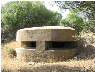
Lámina 27. Nido de ametralladoras en La Menacha Algeciras. replanteo semicircular peraltado.
