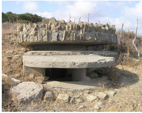
Lámina 32. Nido con cubierta simple hormigonada, Bolonia, Tarifa.
