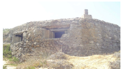
Lámina 38. Elemento 323c. Obra en caverna ejecutada con hormigón fino con árido del lugar, playa de Getares, Algeciras.
