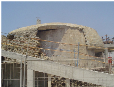
Lámina 38. Elemento 323c. Obra en caverna ejecutada con hormigón fino con árido del lugar, playa de Getares, Algeciras.
