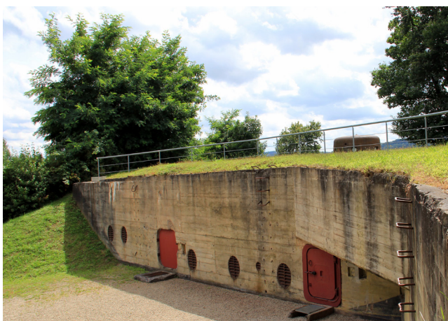
Figura 4. Ejemplo de obra acasamatada de un puesto defensivo de combate, compuesto y camuflado mediante capa de terreno vegetal en Besseringen (Alemania).
