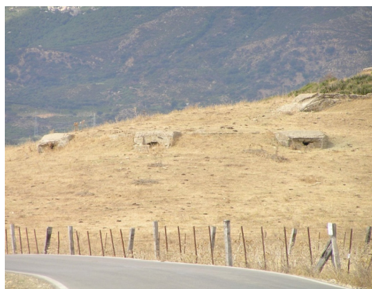
Lámina 13. Obra en caverna compuesta con elementos agrupados por galerías, en la carretera de Puertollano, Tarifa.
