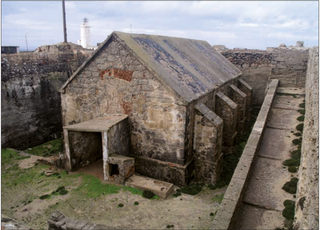
Lámina 21. Vista general del almacén de pólvora de San Antonio. Imagen de Ángel Sáez
