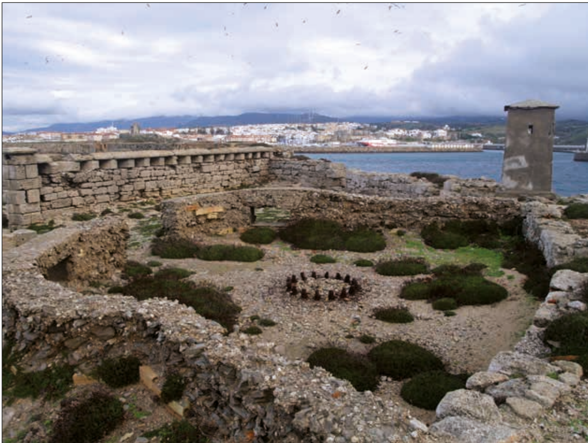
Lámina 10. Interior de la Batería de San Antonio. Obsérvese el sistema constructivo empleado para la erección del muro de la gola. Imagen de Ángel Sáez
