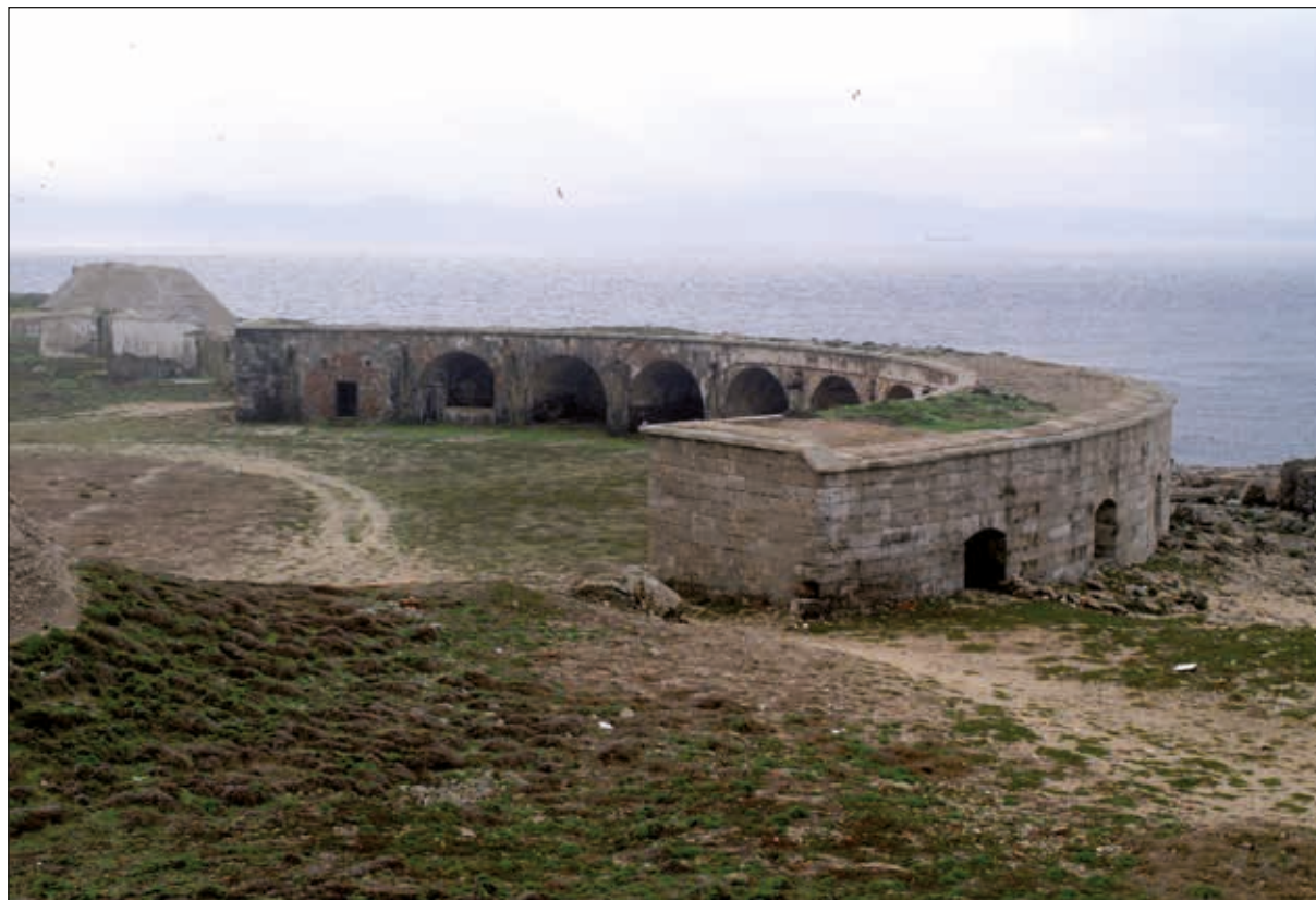
Lámina 13. Vista general desde el norte de la Batería Acasamatada de Poniente. Imagen de Ángel Sáez
