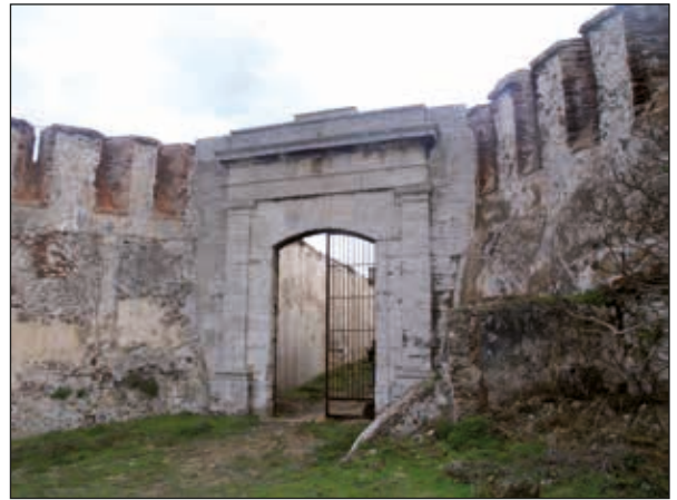
Lámina 16. Alzado exterior de la Puerta de Carlos III y muros perimetrales aspillerados. Imagen de Ángel Sáez
