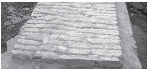
Lámina 5. Detalle de la cimentación del arsenal califal de Algeciras construida a base de piezas dispuestas a tizón.
