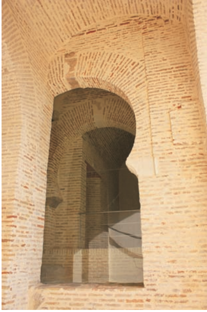
Fig. 11: Puerta de la Pescadería en Aznalcázar, desde el primitivo espacio interior de la torre-puerta. El arco que aparece en segundo término, tras el cristal, es el arco exterior con una quicialera e imposta original que ha servido como modelo para la restitución de la imposta del arco en primer término.
