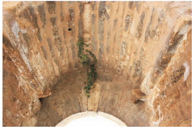
Fig. 6: Detalle de las quicaleras y bóveda sobre hiladas voladas en la puerta de acceso a la medina de Ágreda.
