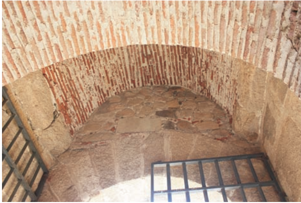
Fig. 5: Detalle de las quicaleras y bóveda sobre hiladas voladas en la puerta de acceso al Castillo de Trujillo
