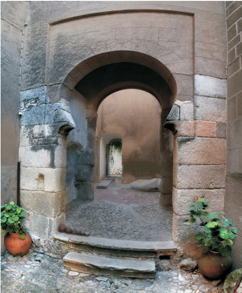
Fig. 8: Fotomontaje del arco exterior de la Porta do Templo, en la que se distingue claramente la sillería almohade de la refacción contemporánea.
