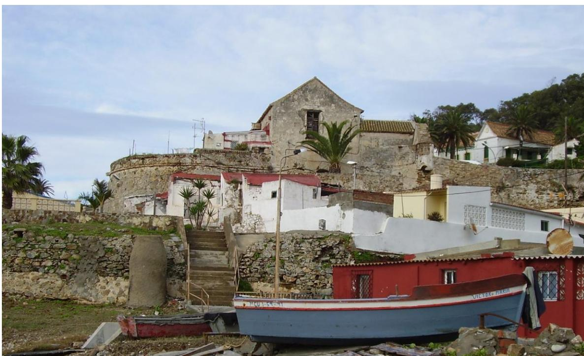
Este conjunto combina dos cuerpos para la defensa de costas. Por un lado, el más destacado y llamativo, se compone de un tronco de cono ataludado elevado en cuya terraza se emplazaban los cañones a la barbata, y por otro, una batería terraplenada más amplia con troneras situada por debajo de la anterior unos 7,00 metros.
